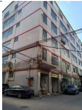
东南面—A 栋工业厂房
