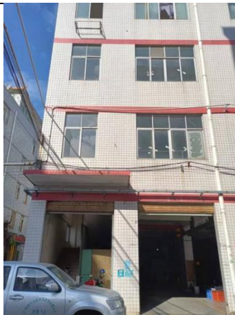
西北面—C 栋工业厂房
